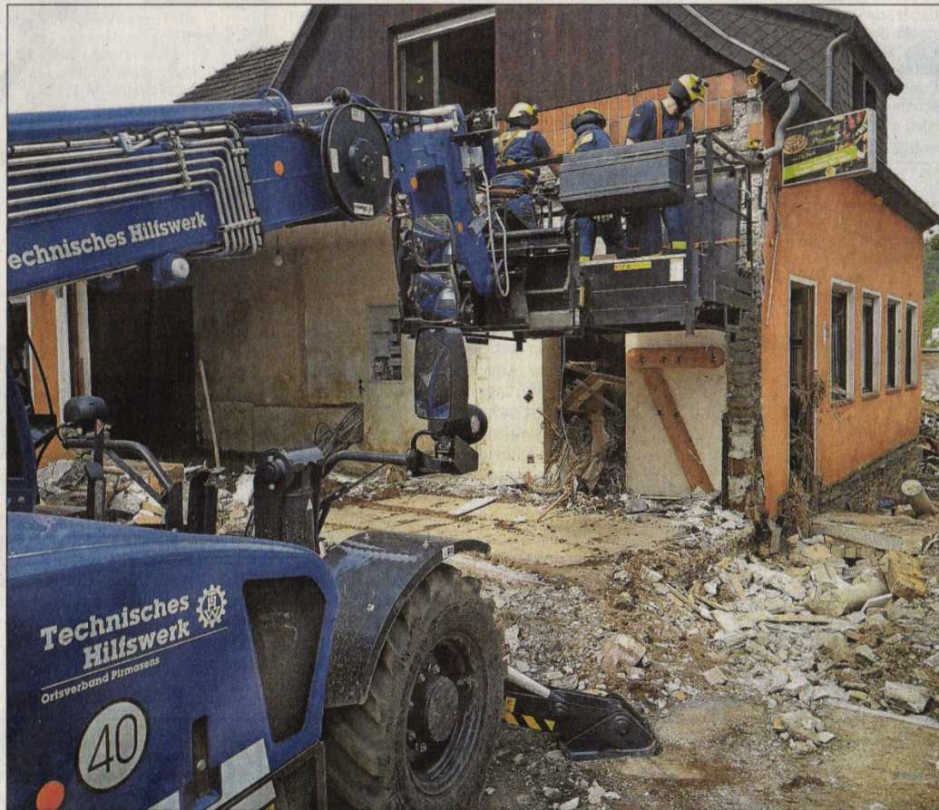
Am Ortseingang der Gemeinde Schuld half der THW-Ortsverband Pirmasens mit seinem Teleskopstapler bei der Sicherung. In einer ehemaligen Pizzeria musste ein Öltank entfernt werden, bevor das Haus zum Einsturz gebracht werden konnte.
