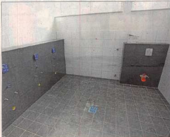
Die Dusch- und Toilettenräume sind fast fertig.
