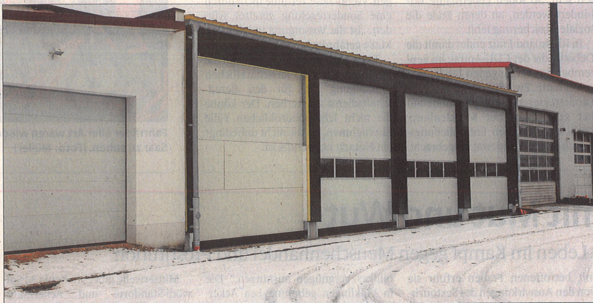
Die neue Fahrzeughalle auf der Nordseite des künftigen THW-Gebäudes. (Foto: Scharf)
