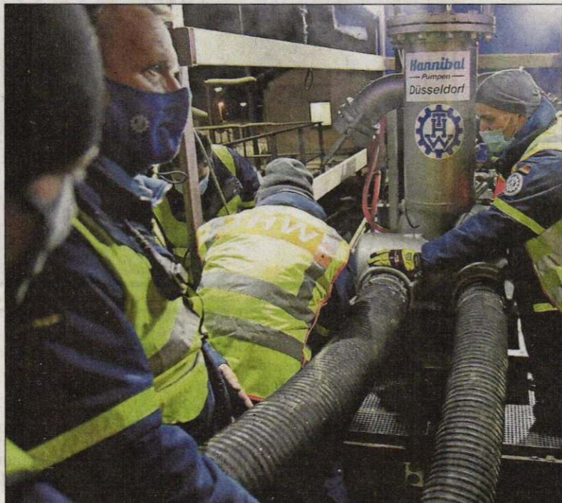
Die Fachleute des THW, die mit 40 Einsatzkräften vor Ort waren, installieren eine Hannibal-Großpumpe, die das Abwasser von Bann nach Queidersbach befördert.
