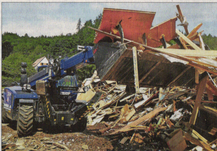
Hier standen einmal Häuser an einer Straße: Mit ihren Maschinen räumte die Pirmasenser THW-Einsatzgruppe den Weg frei, um eine neue Schotterstraße anzulegen. Der Einsatz war notwendig, damit Kanalspülfahrzeuge anfahren konnten, damit das Abwasser wieder abfließen kann. (Foto: Maurer)
