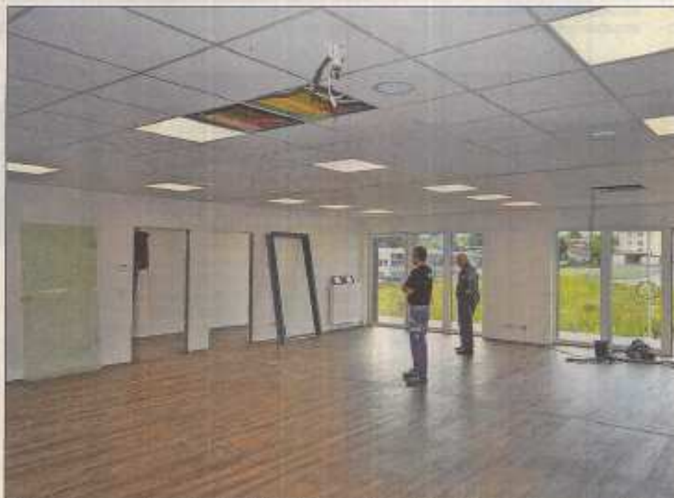
Wohl bis heute Abend werden die THW-Helfer noch mit den letzten Feinarbeiten am neuen Domizil zu tun haben.
