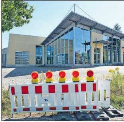
Für das THW gesperrt: das ehemalige Autohaus Klos & Schmidt auf der Husterhöhe. FOTO: BUCHHOLZ
