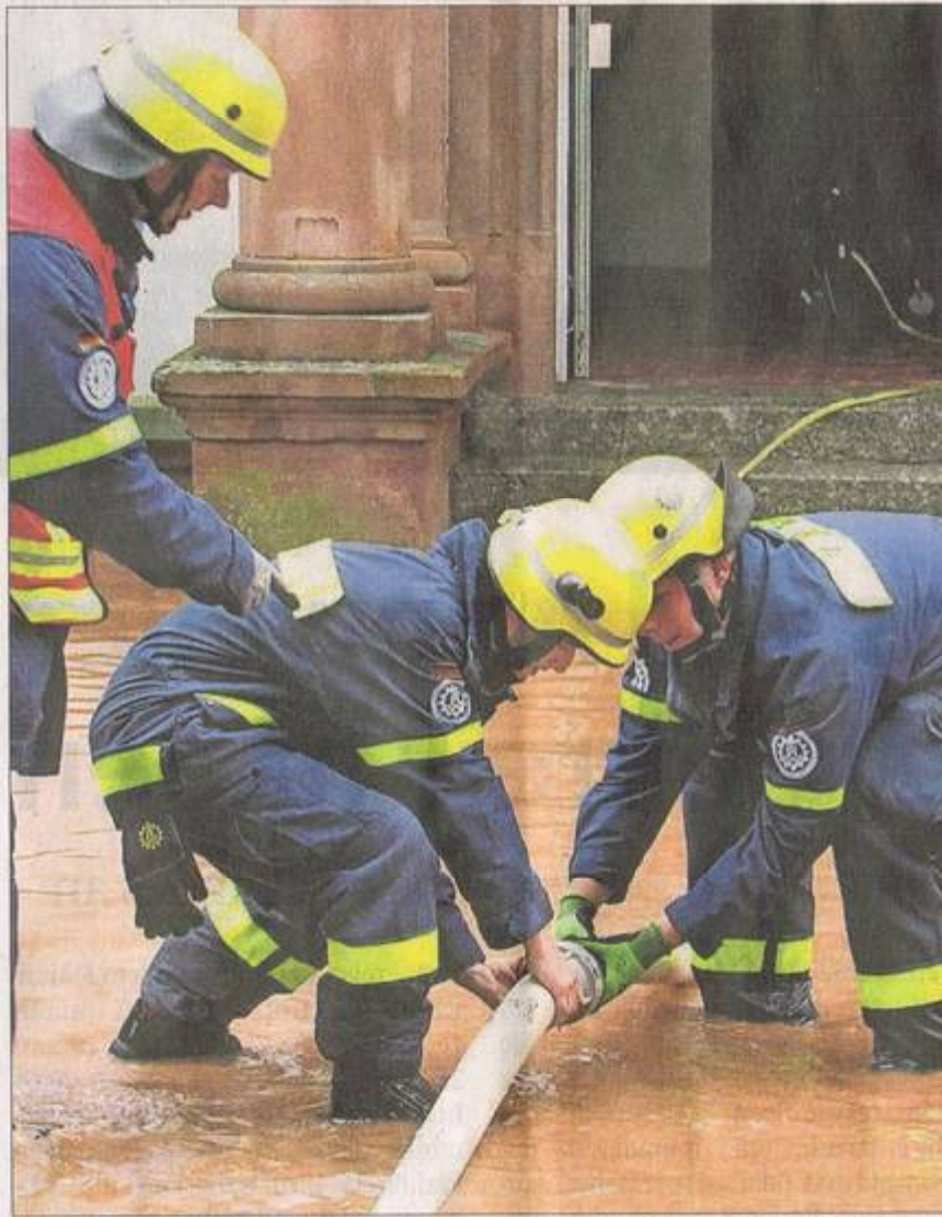
Helfer des Technischen Hilfswerks legen Schläuche, um das überschwemmte Wasserwerk leerzupumpen. (Foto: THW)
